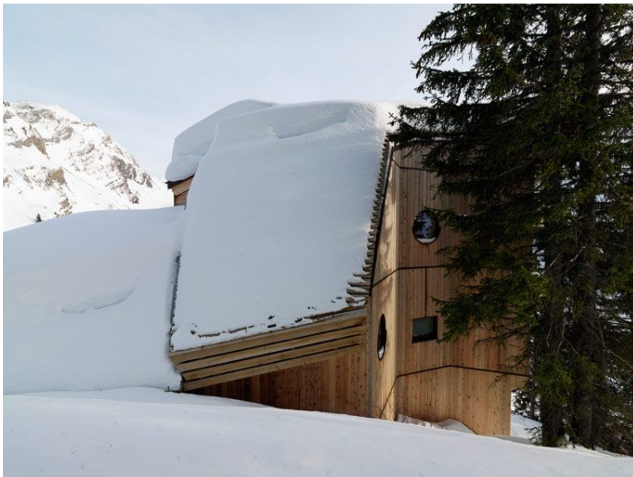
Vue depuis la route
