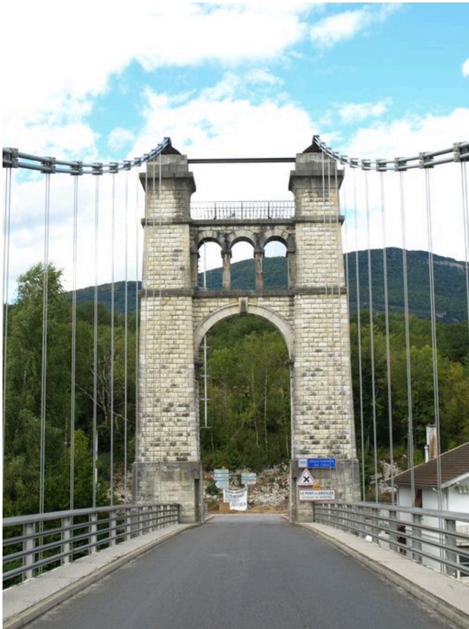
Vue partielle, de dessus, suspentes et câbles porteurs, pylône droit (depuis la rive gauche)
