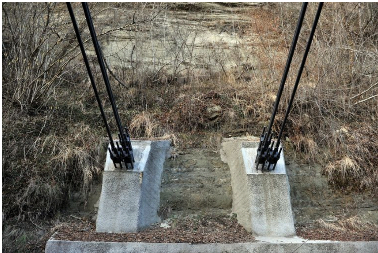
Rive droite : massif et câbles d'ancrage
