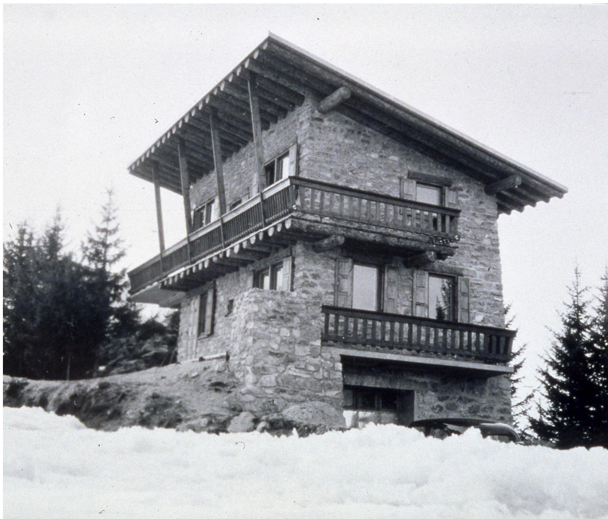
Vue depuis le nord-est. Photogr. vers 1955
