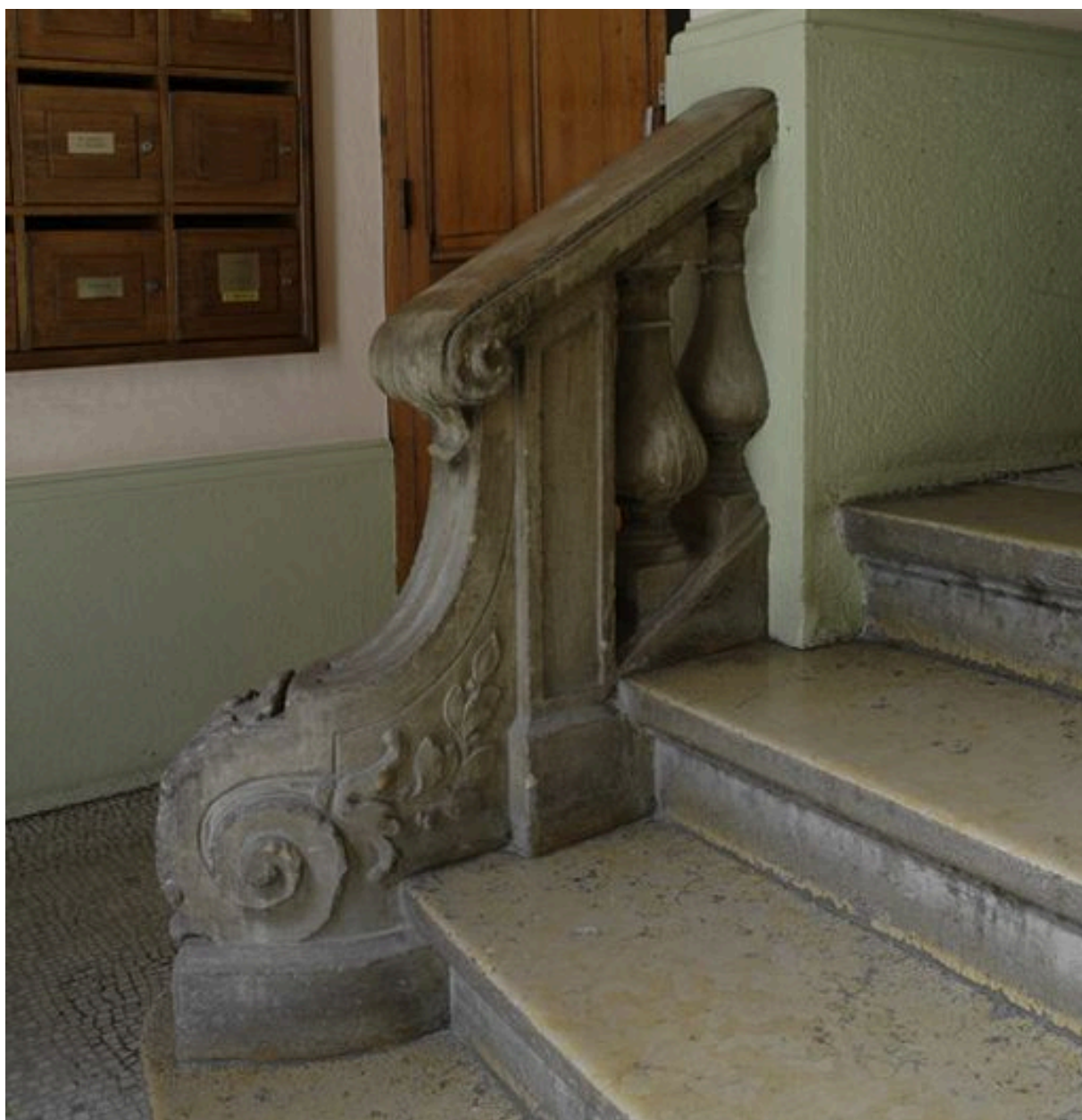
Détail du garde-corps du degré du vestibule
