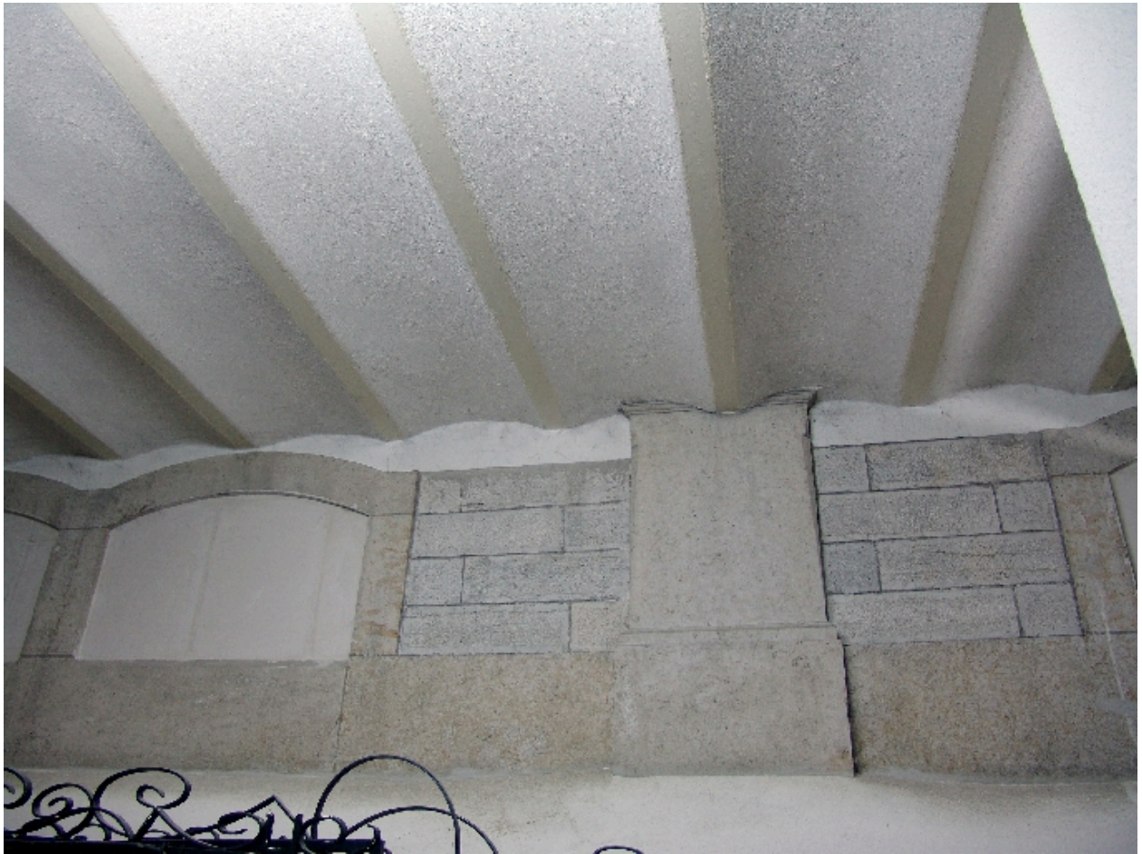
Etage de soubassement, partie technique est : voûte
