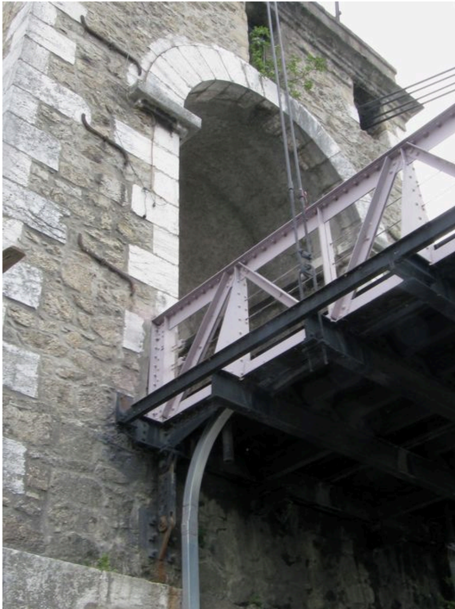
Pile gauche, face amont, vue partielle : jonction avec le tablier (depuis la rive gauche)
