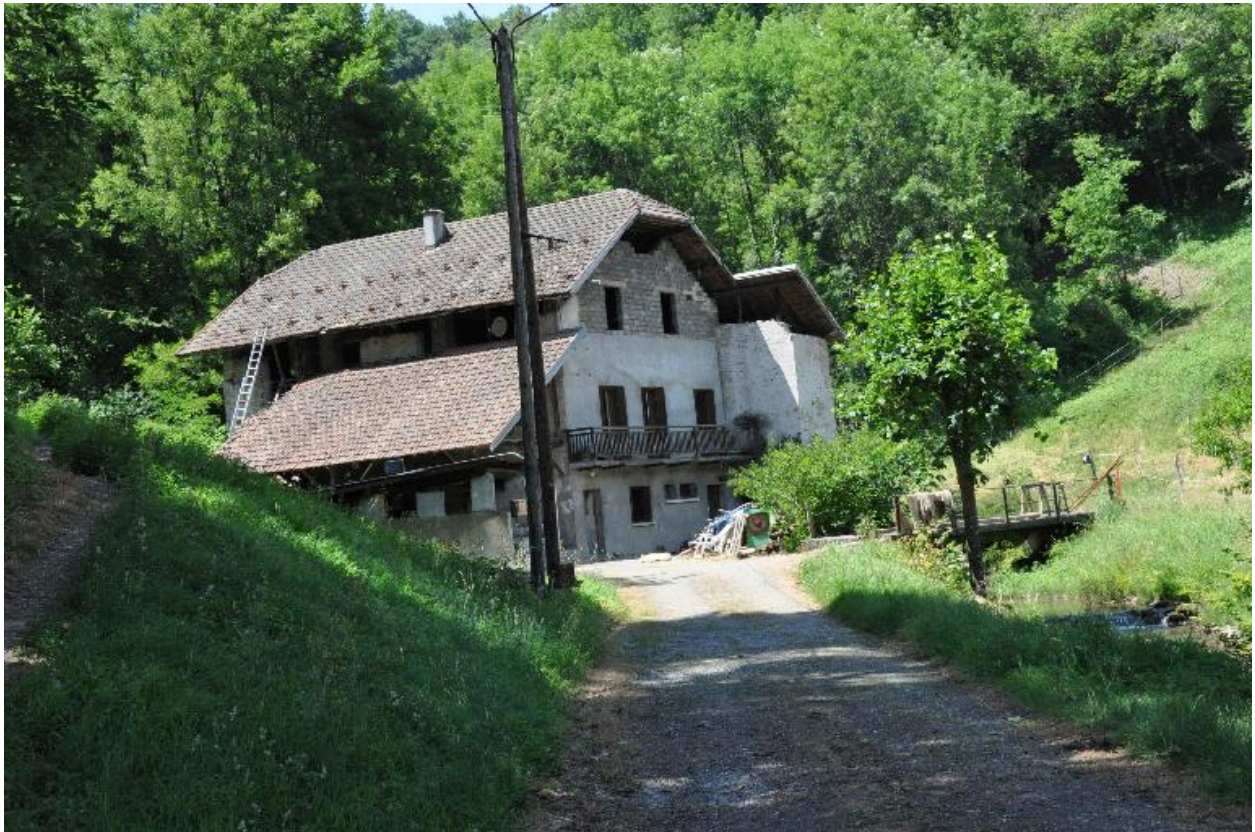
Pignon sud du moulin aval.
