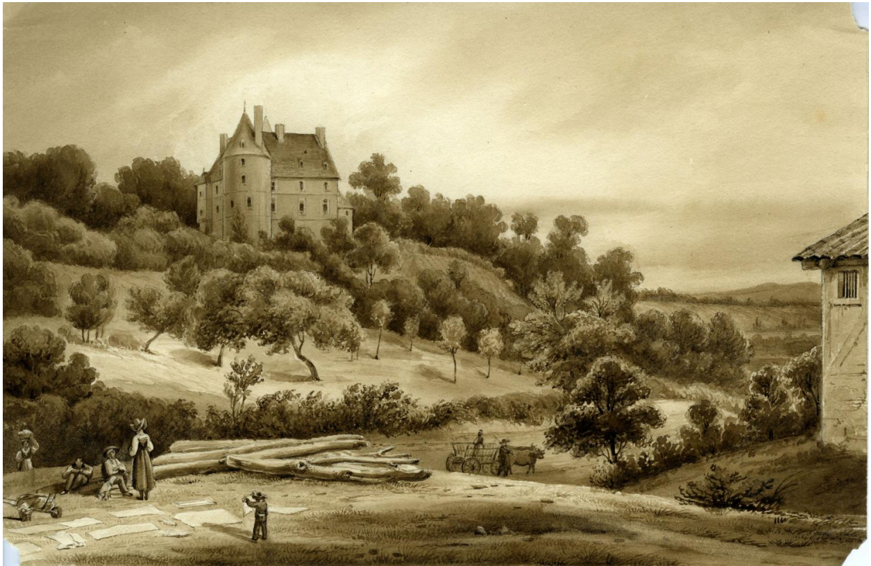
Vue sud avant travaux
