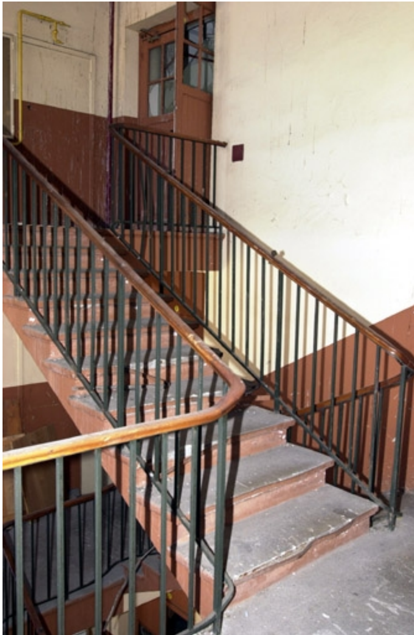
Bâtiment d'entrée, escalier
