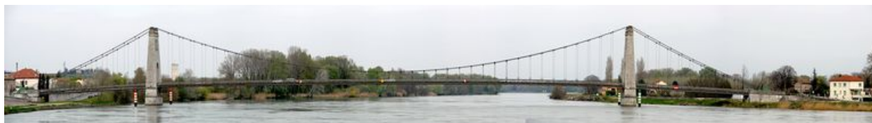
Vue panoramique, côté aval
