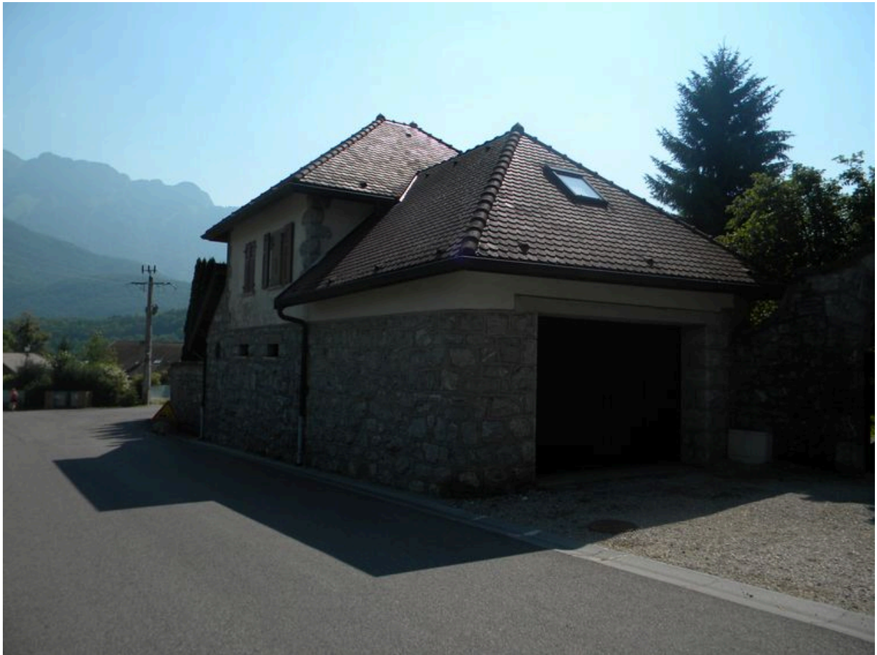
Vue amont de la dépendance d'une maison bourgeoise près de Loche (2008 A2 1223).
