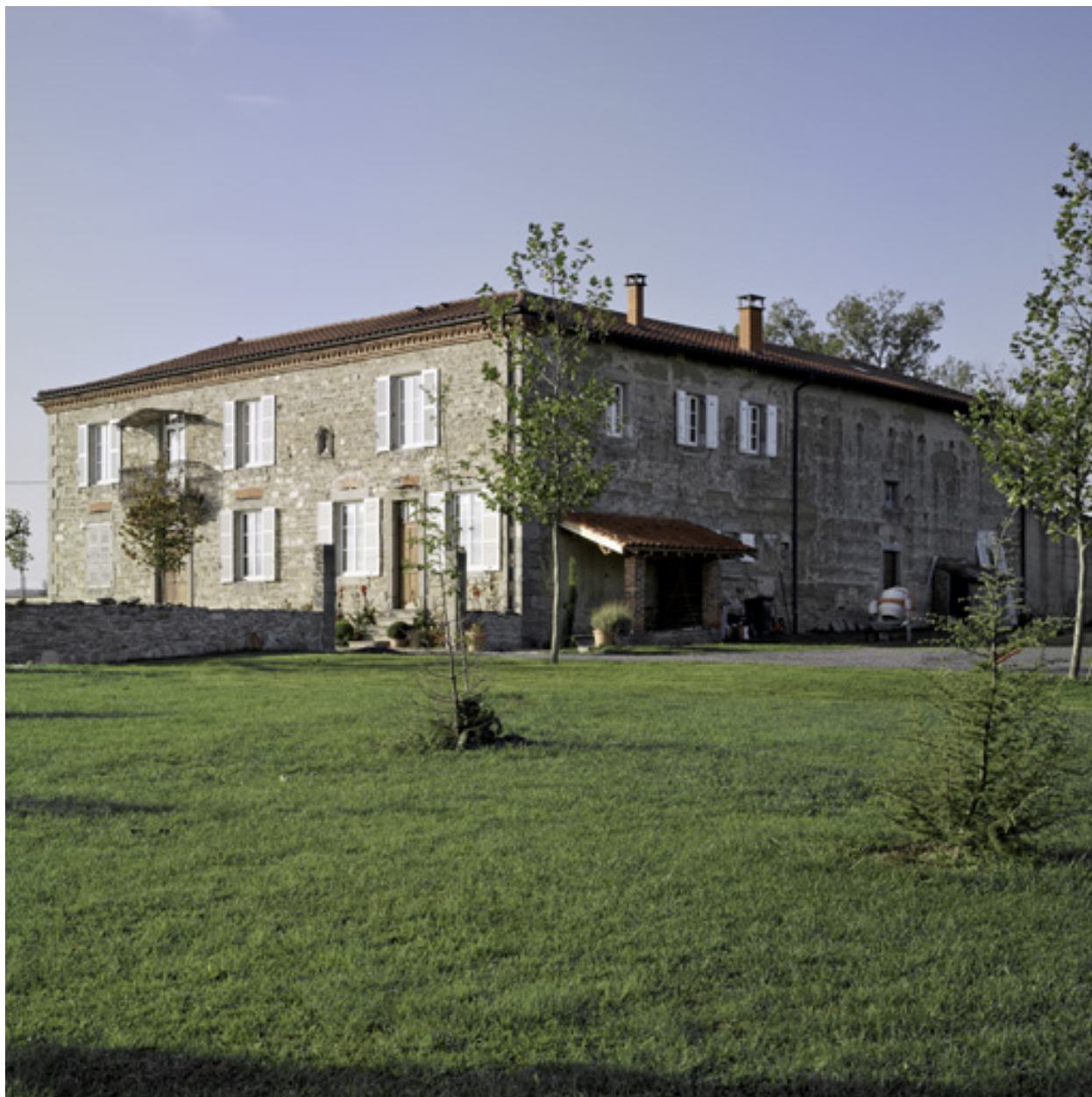
Vue d'ensemble de la demeure depuis le nord-est.
