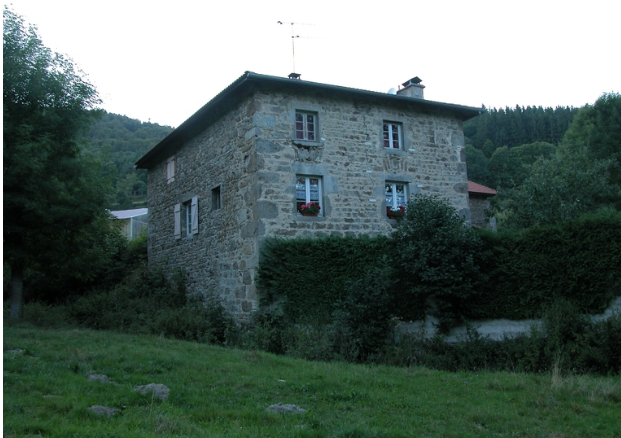
Vue du moulin depuis le sud-est.
