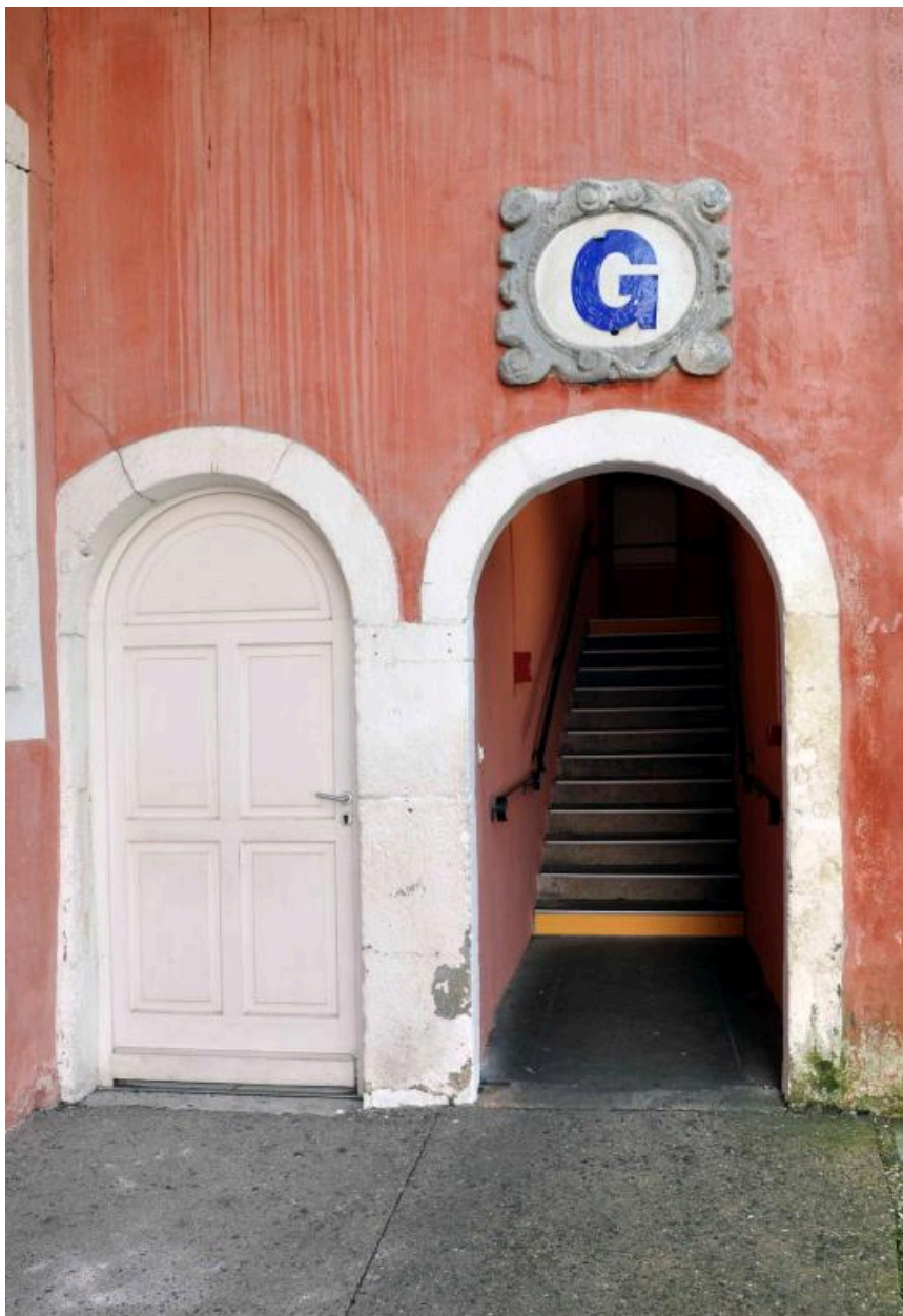
Bâtiment A, double baie et escalier sud
