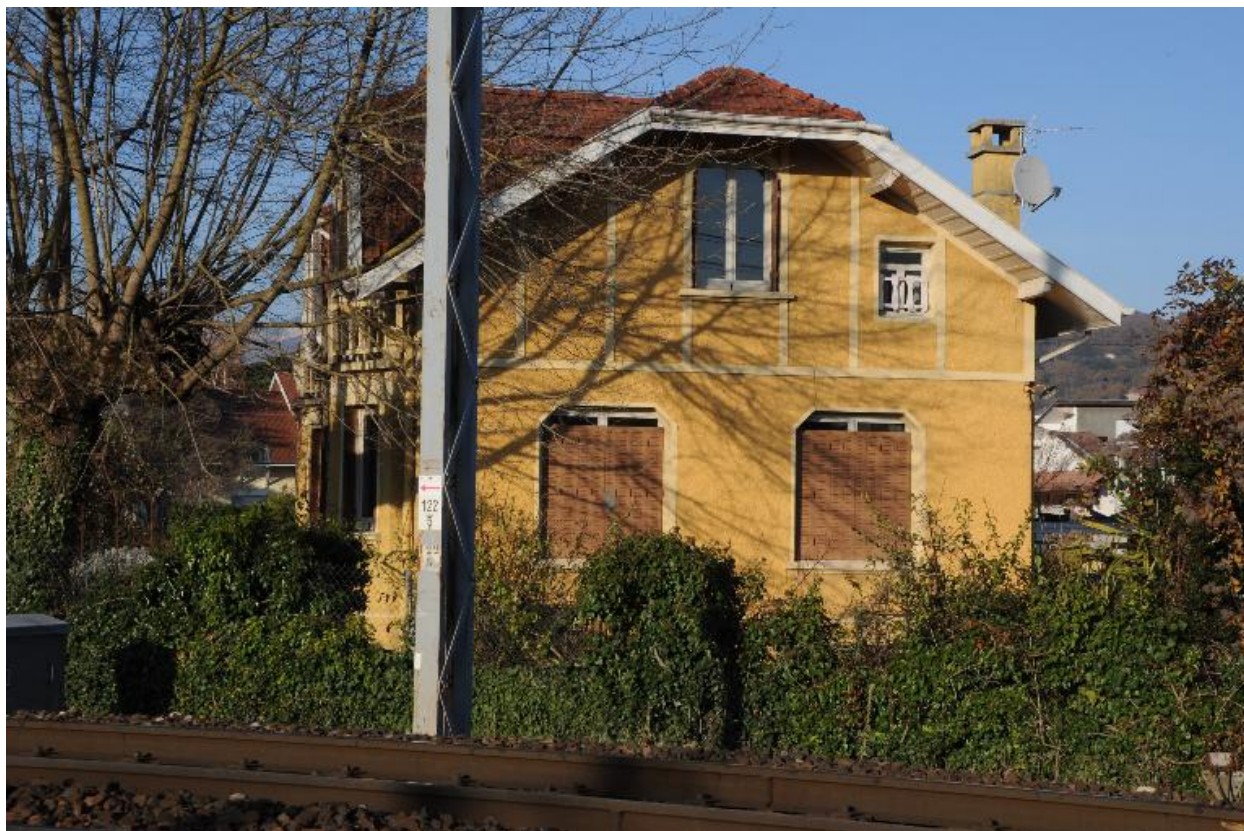
Façade latérale droite
