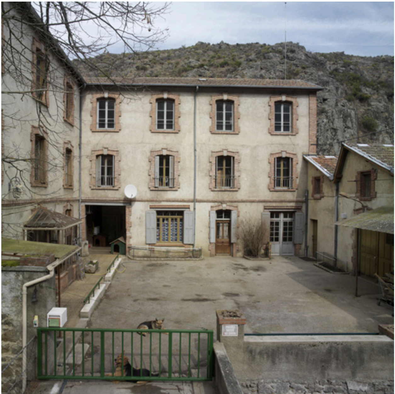
Vue de la cour, depuis le sud.
