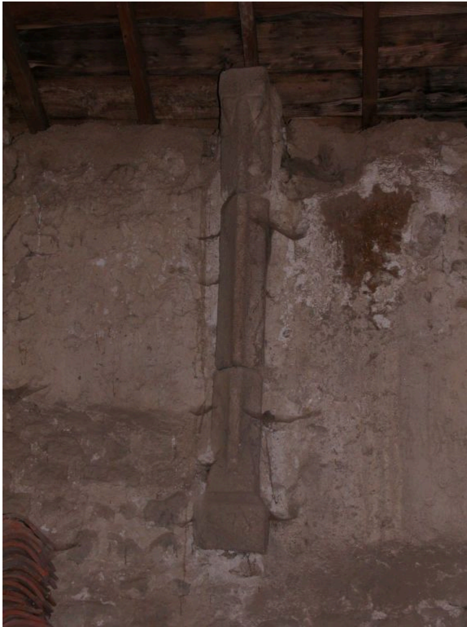
Celle C 472. Grange-étable, détail d'un piédroit de cheminée.
