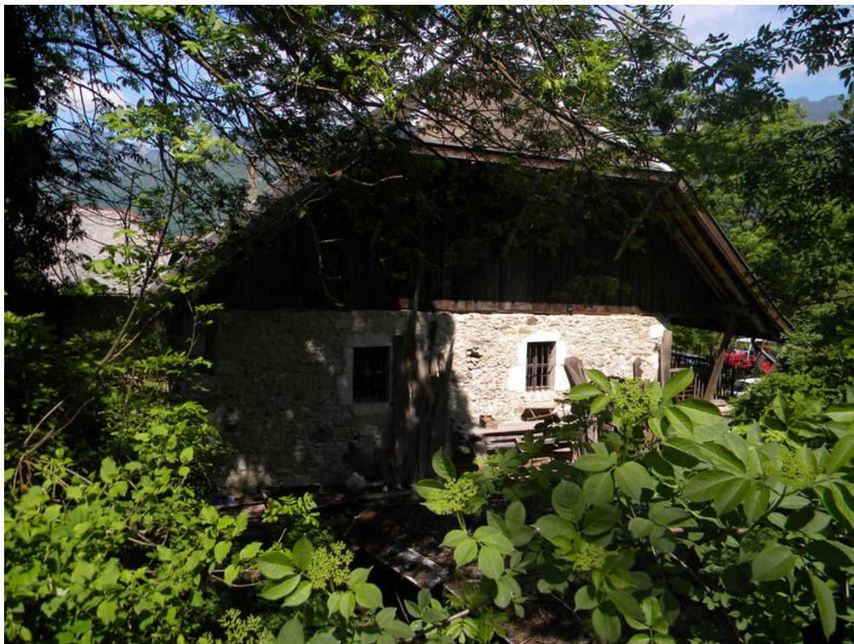
Vue du pignon sud.
