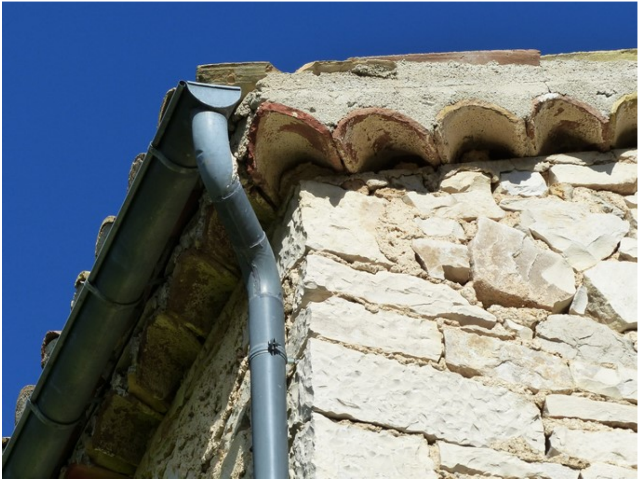
Angle sud-ouest, passage du rang de génoise de l'avant-toit vers la saillie de rive.
