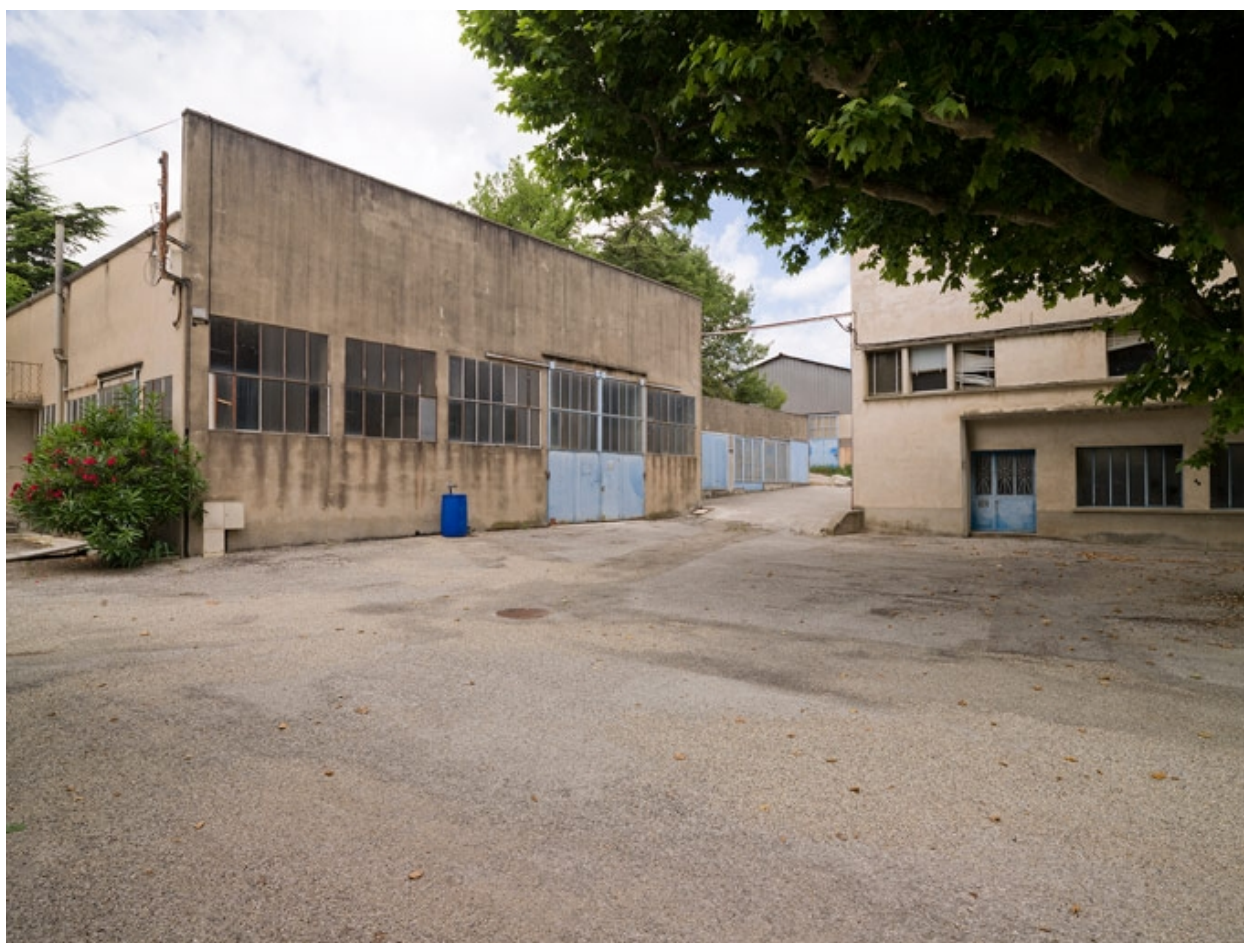
Vue d'ensemble est
