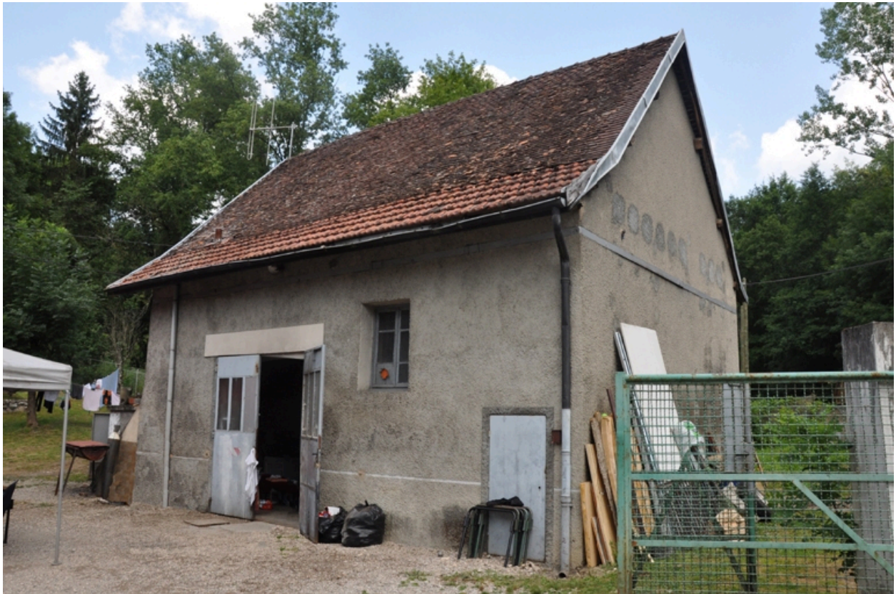
Vue générale de l'ancien bâtiment de la salle des machines, façades sud et ouest
