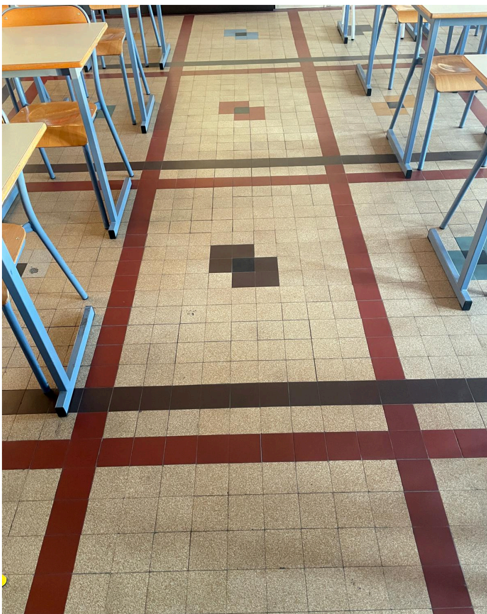
Pavillon sud, salle de classe au 5e étage : détail du carrelage en grès cérame
