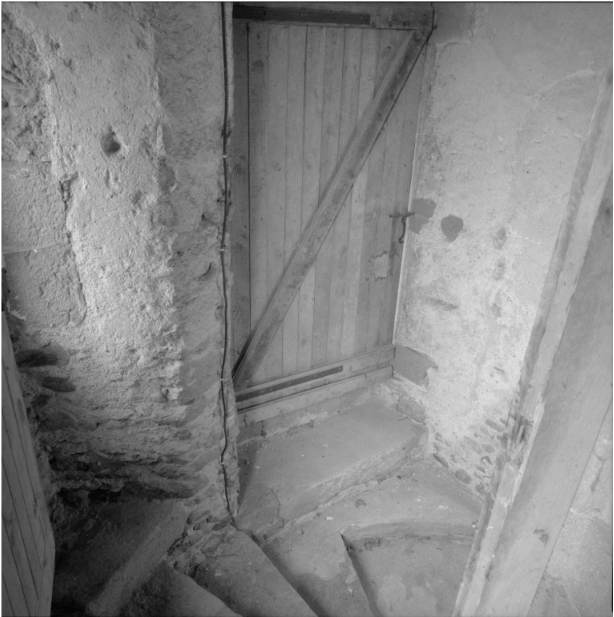
Corps de galerie, rez-de-chaussée, tour d'escalier nord-ouest : vue de la porte d'accès à la galerie.
