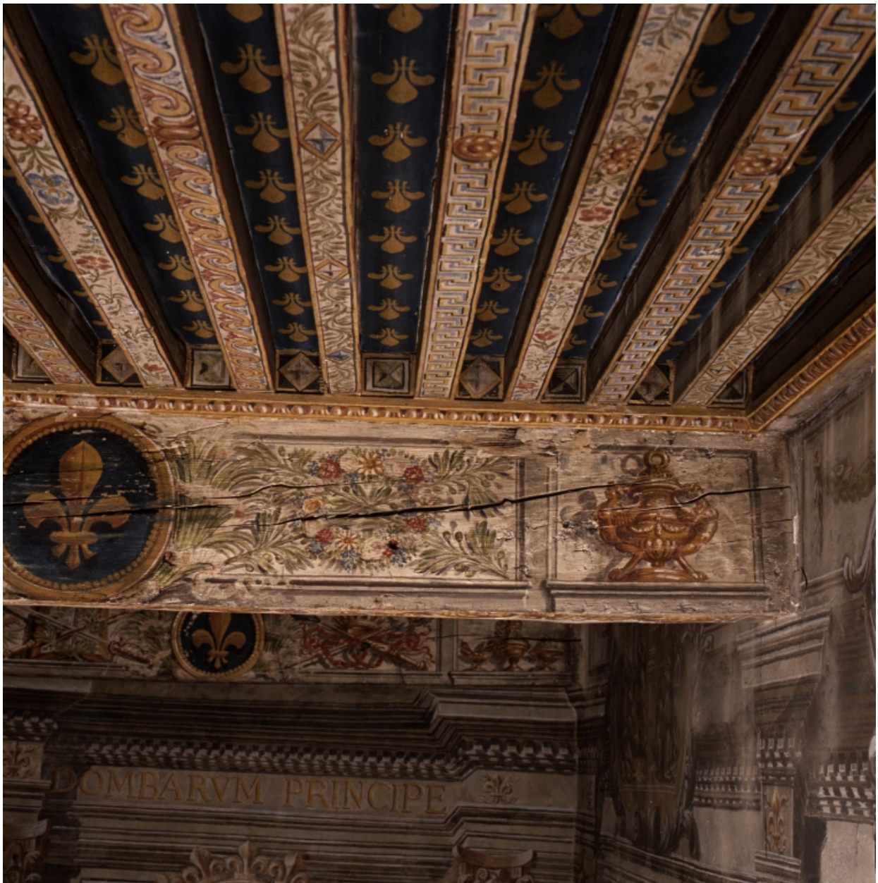
Poutre 2, face sud, extrémité droite.
