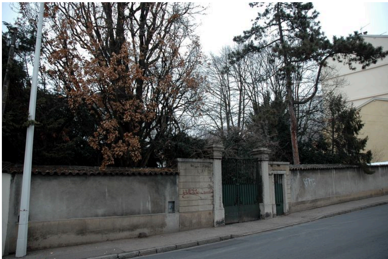
Le mur de clôture
