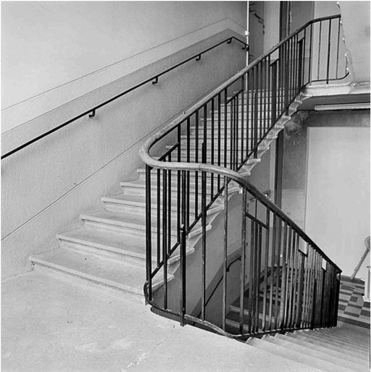
L'un des escaliers
