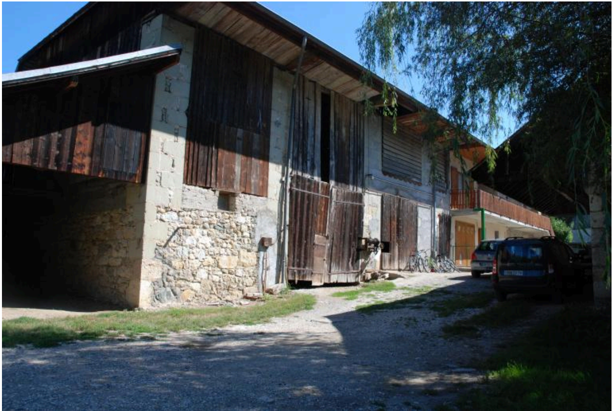
Vue d'ensemble côté cour.
