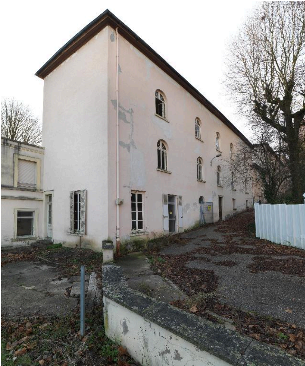
Vue partielle du bâtiment des hommes (aile est, partie nord)
