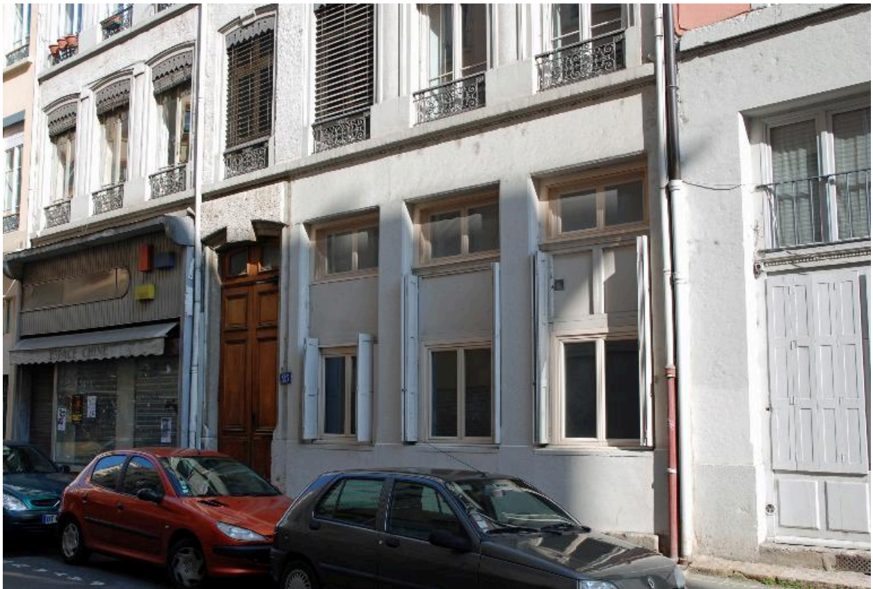
Elévation sur rue, vue rapprochée du rez-de-chaussée
