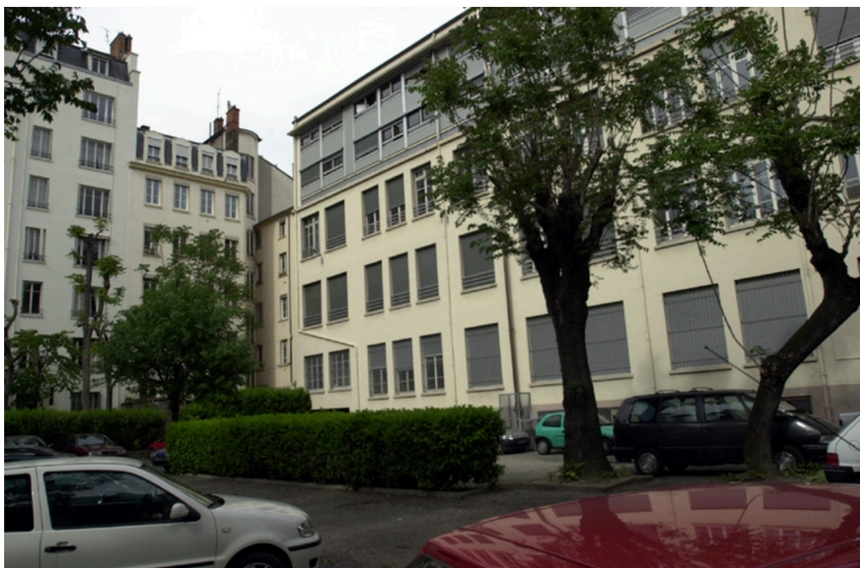
Vue sud-ouest, cour et façade
