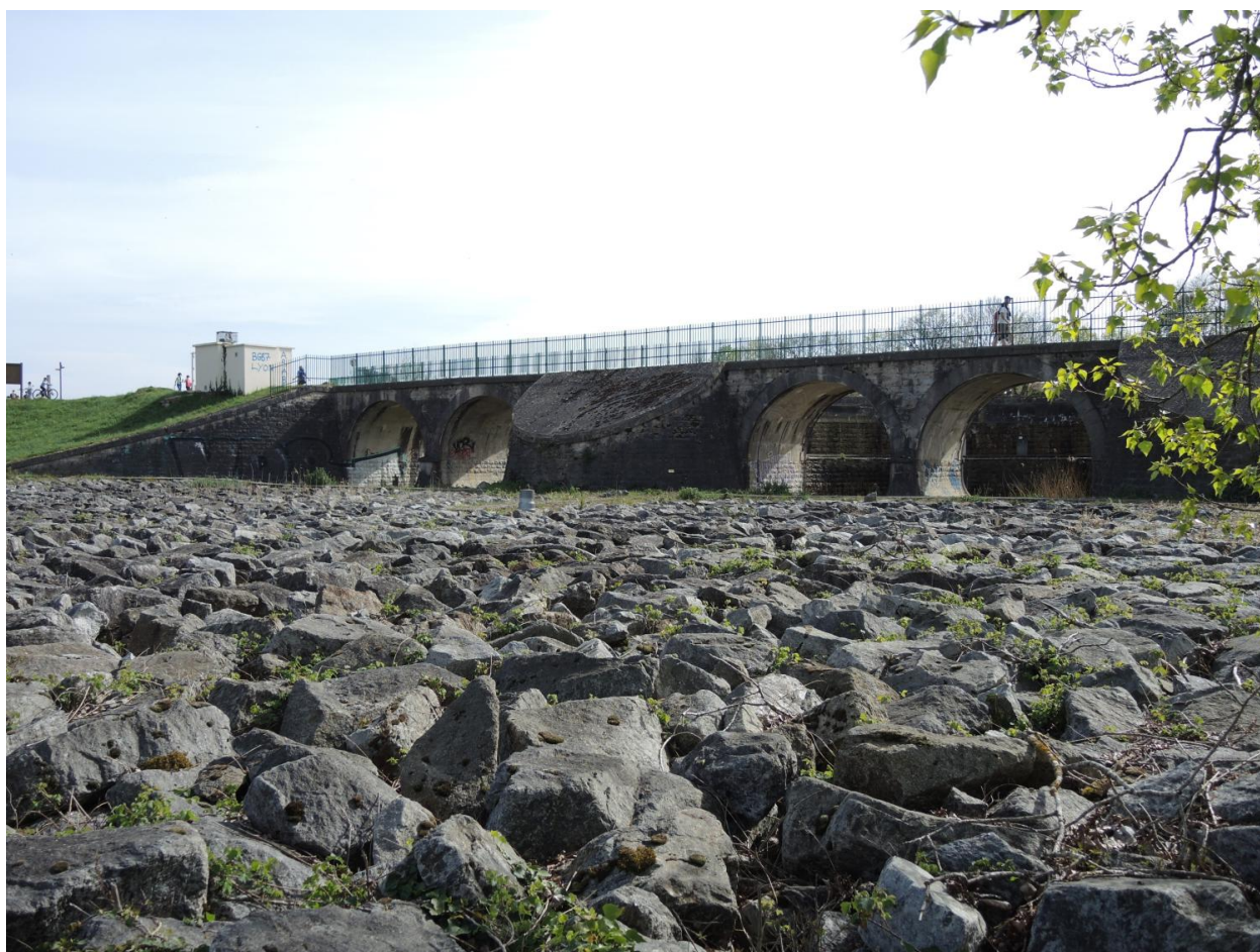
Vue aval du déversoir et enrochement
