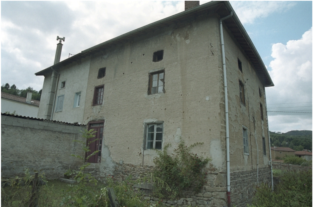
Au Trève, ferme, vue d'ensemble avant droite de trois-quart (1986 C2 962 à 964).
