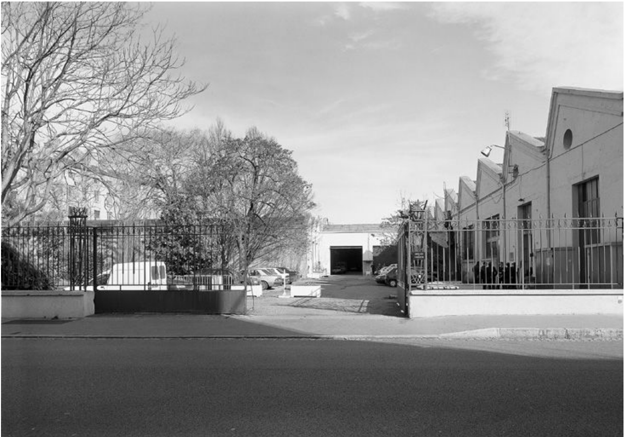
Vue de l'entrée principale, vue sud
