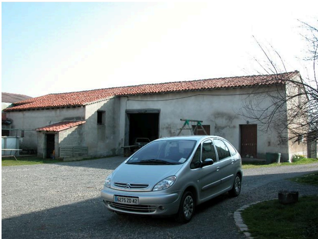
Vue d'ensemble de la seconde grange-étable.
