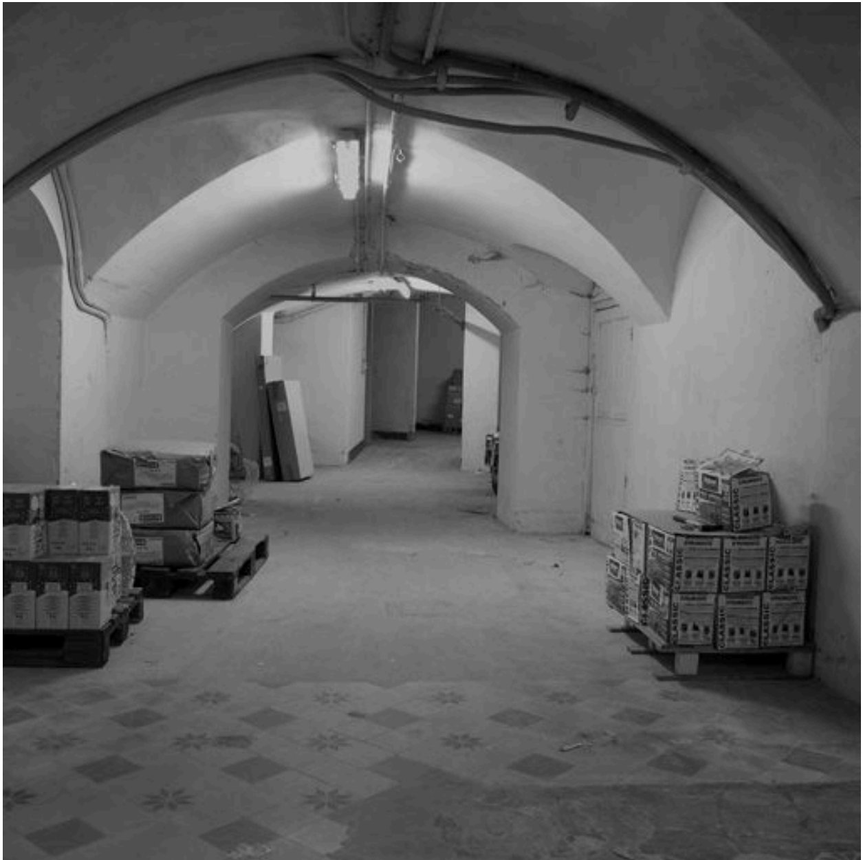
Sous-sol rue Tupin : couloir transversal centre nord, vue depuis l'est
