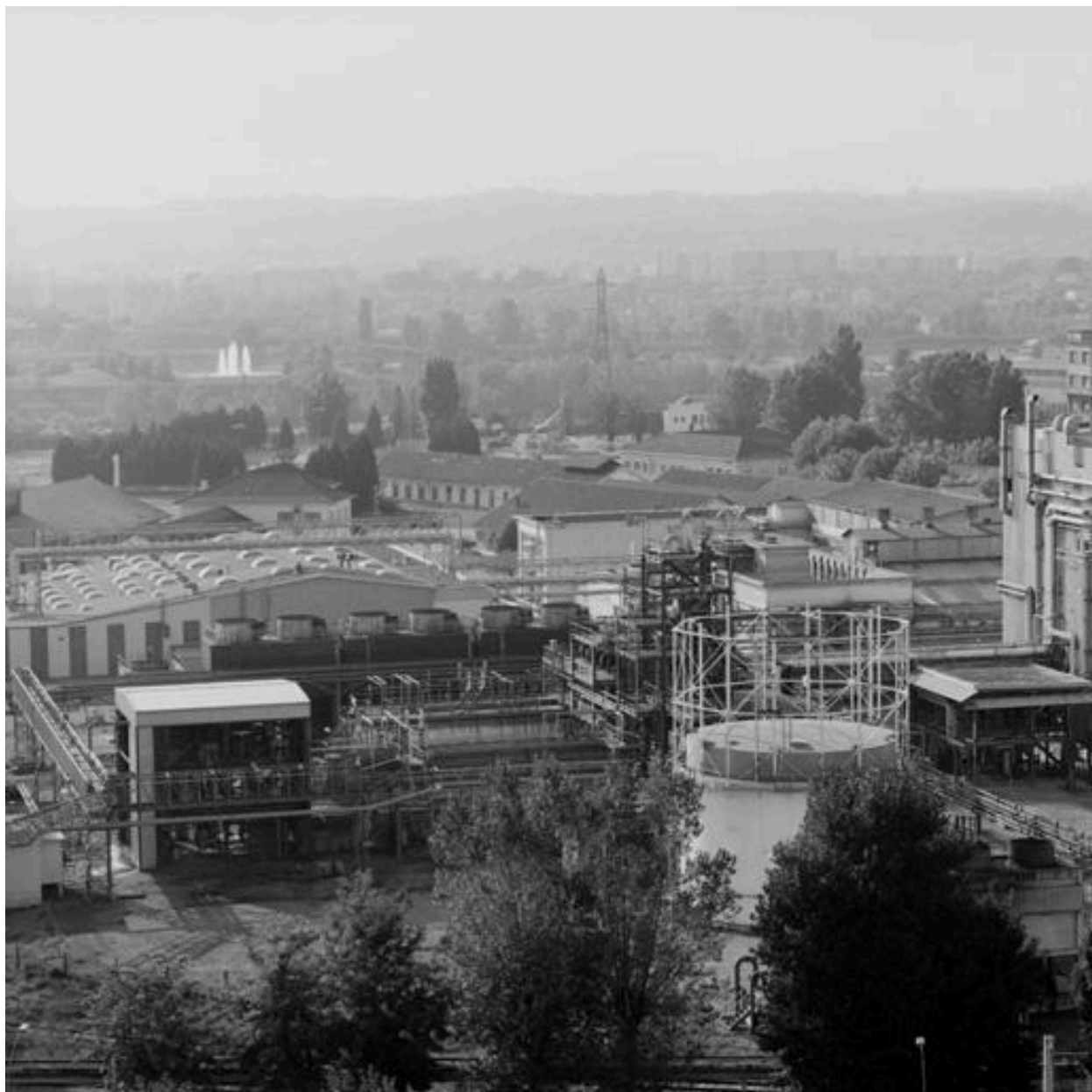
Vue d'ensemble est
