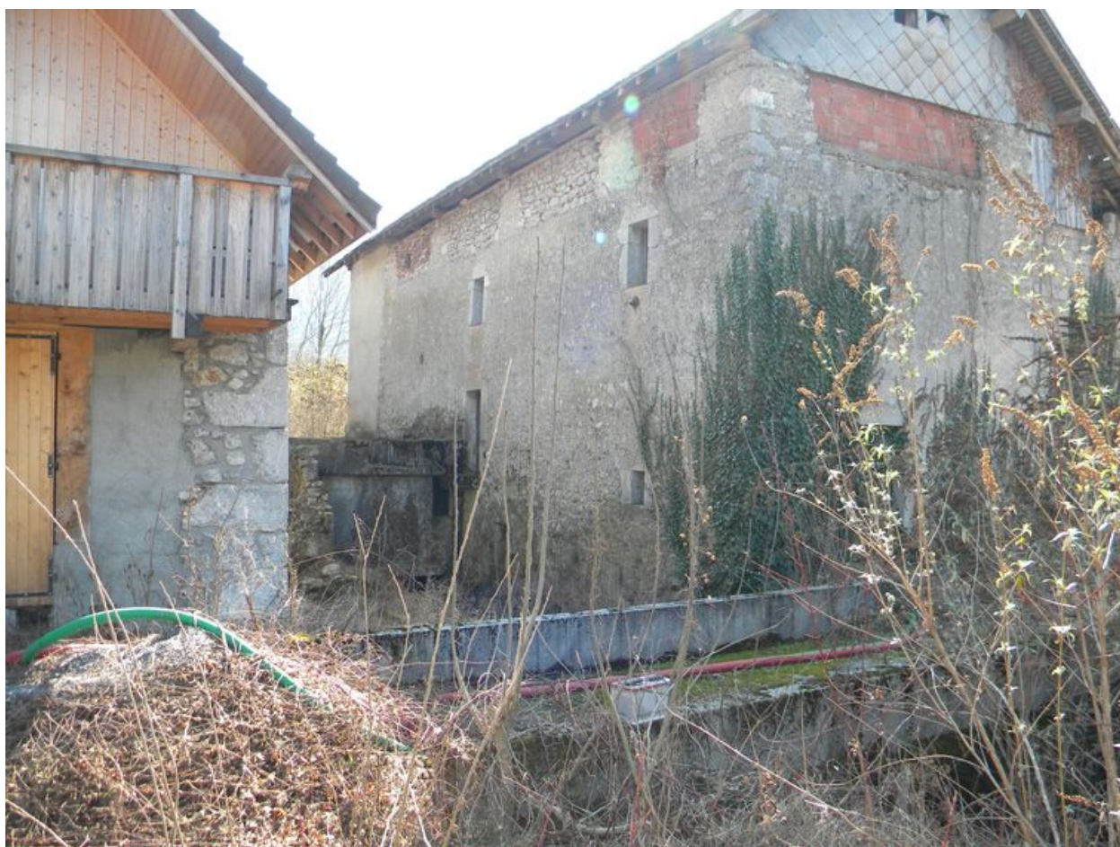
Vue générale du moulin Binvignat à droite avec le pont passant sur le bief séparant les deux moulins.
