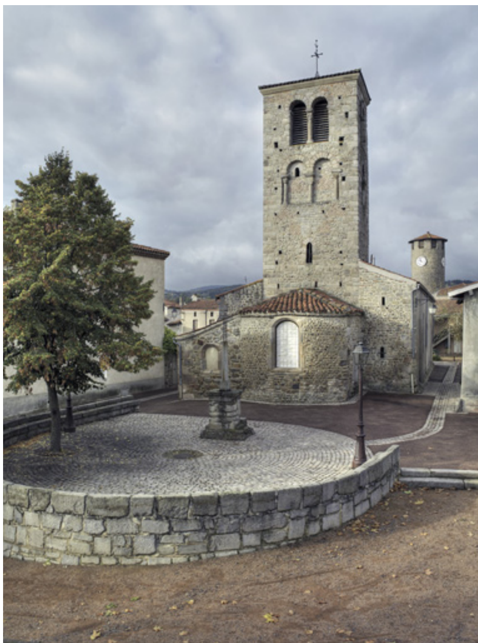
Vue générale de l'église côté est
