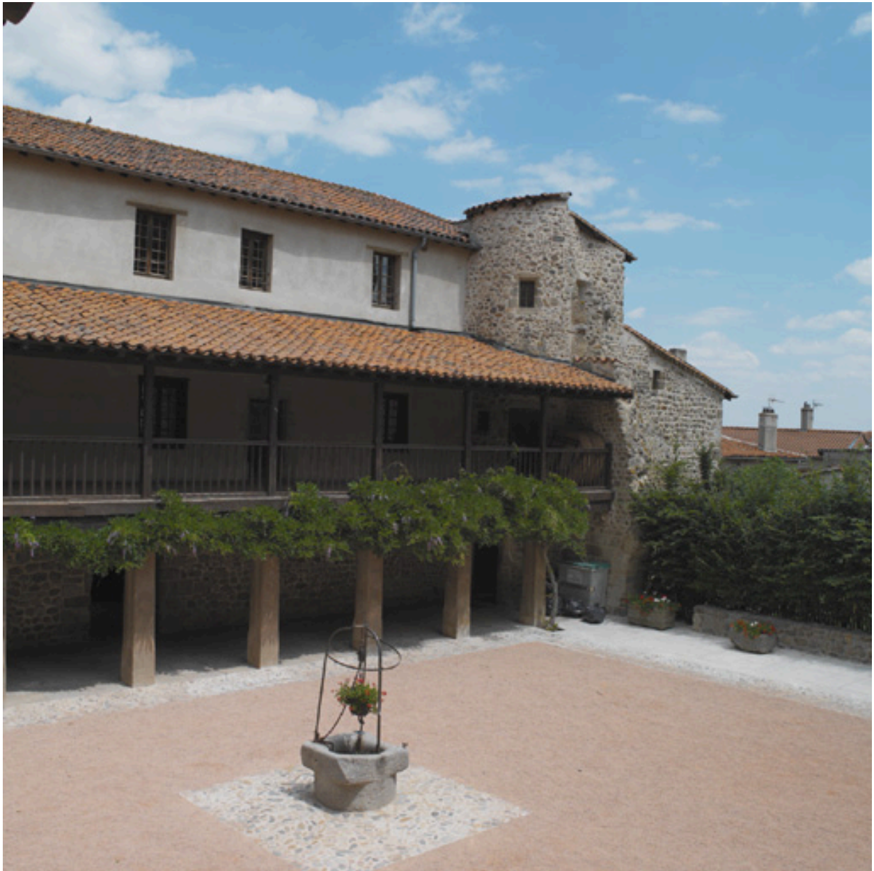
Vue de l'angle nord-est du cloître.
