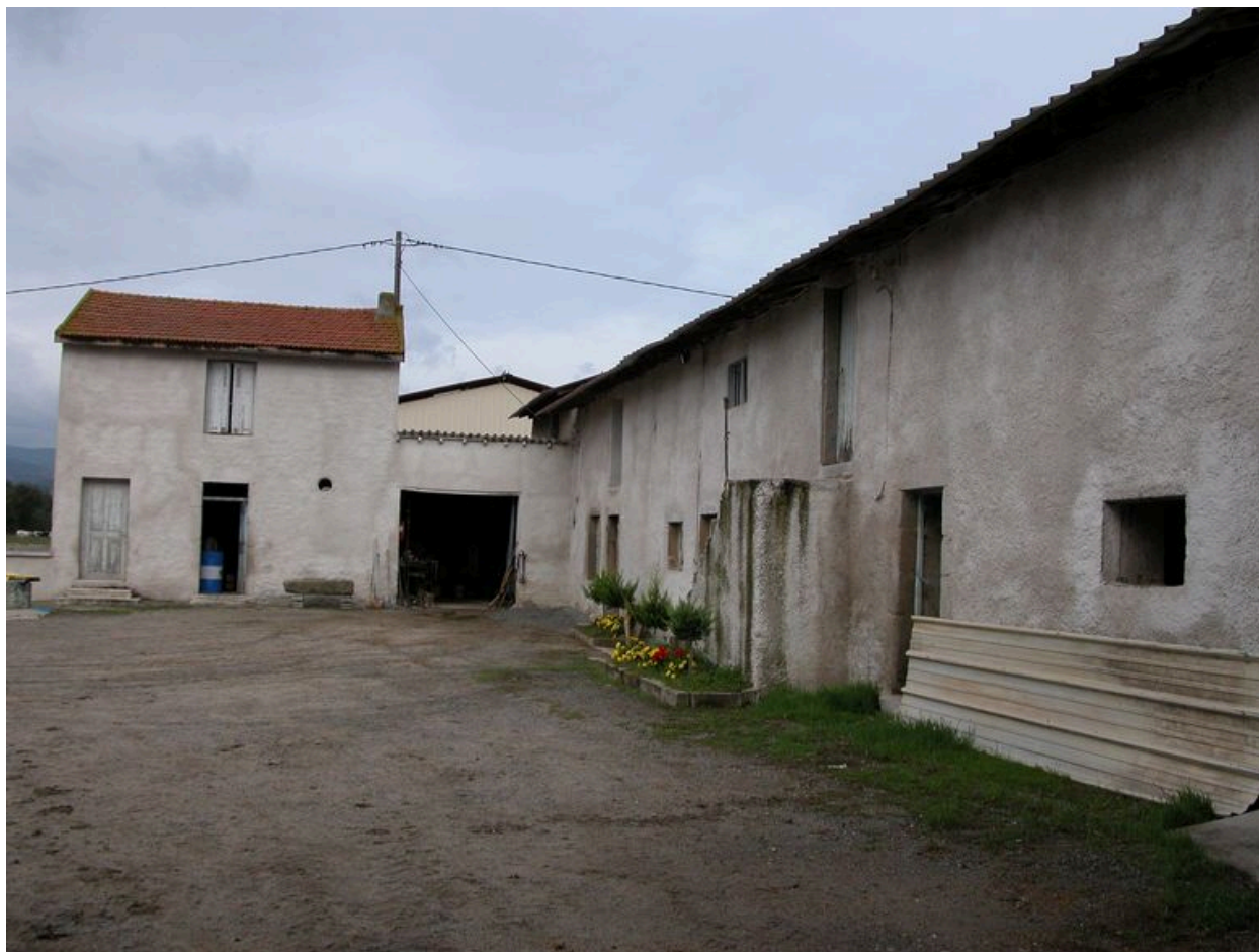
Vue du logis et du fournil, depuis le sud-est.
