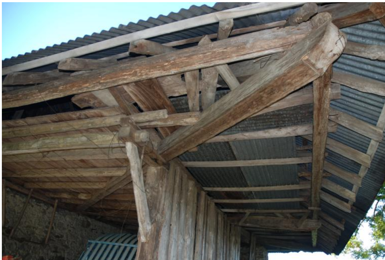
Charpente du débord de toiture du pignon nord.
