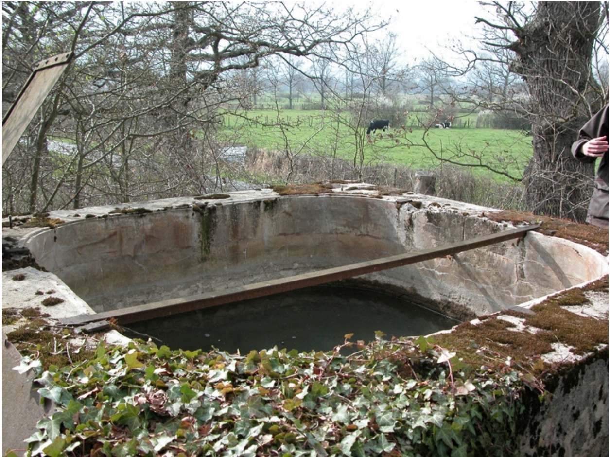
Vue d'un siphon sur le canal du Forez à Barge, le long du chemin n°3 Champdieu-Barge-les Colombons (1986 E2 153).
