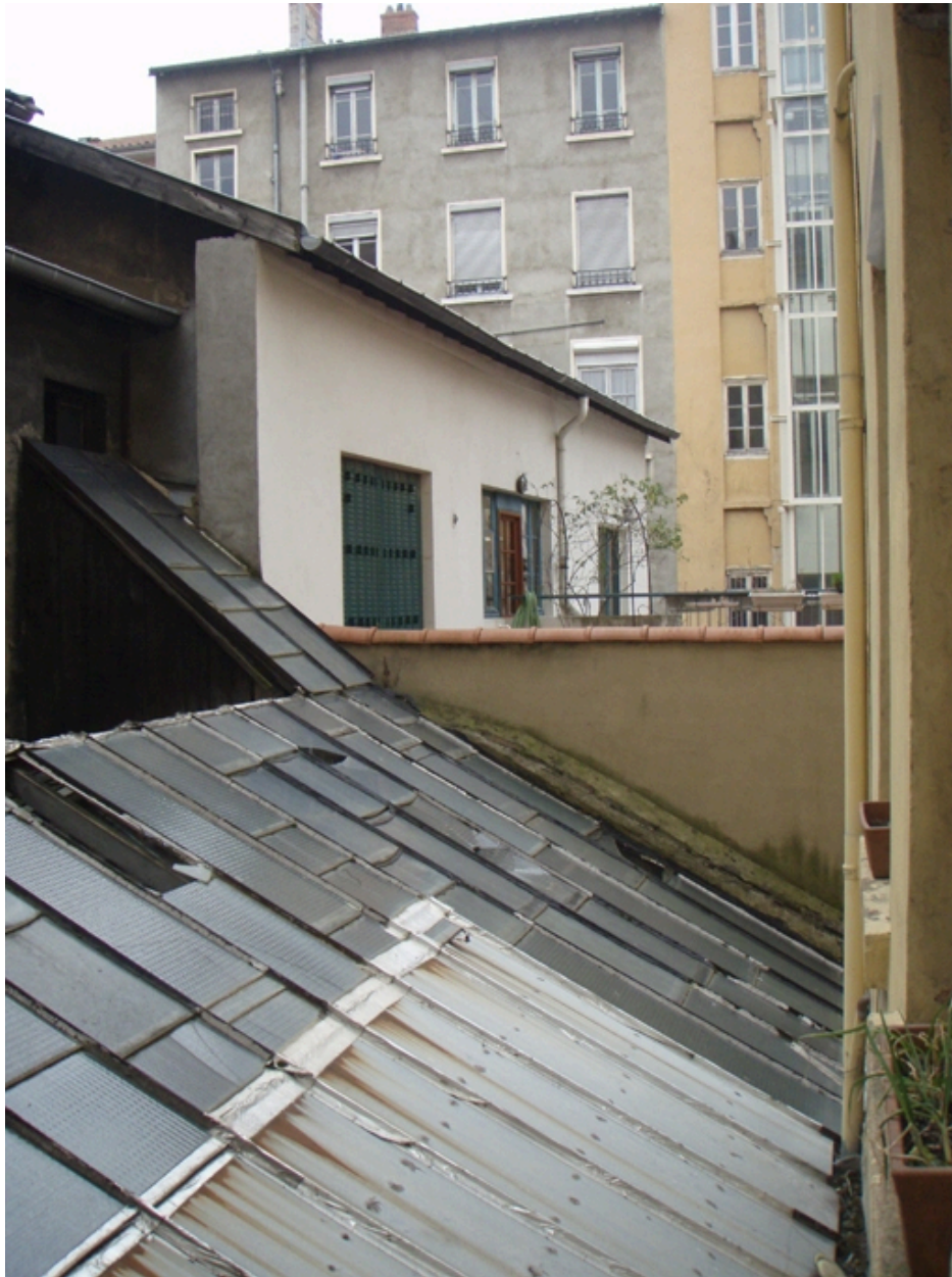
Détail toit à un pans couverture verre
