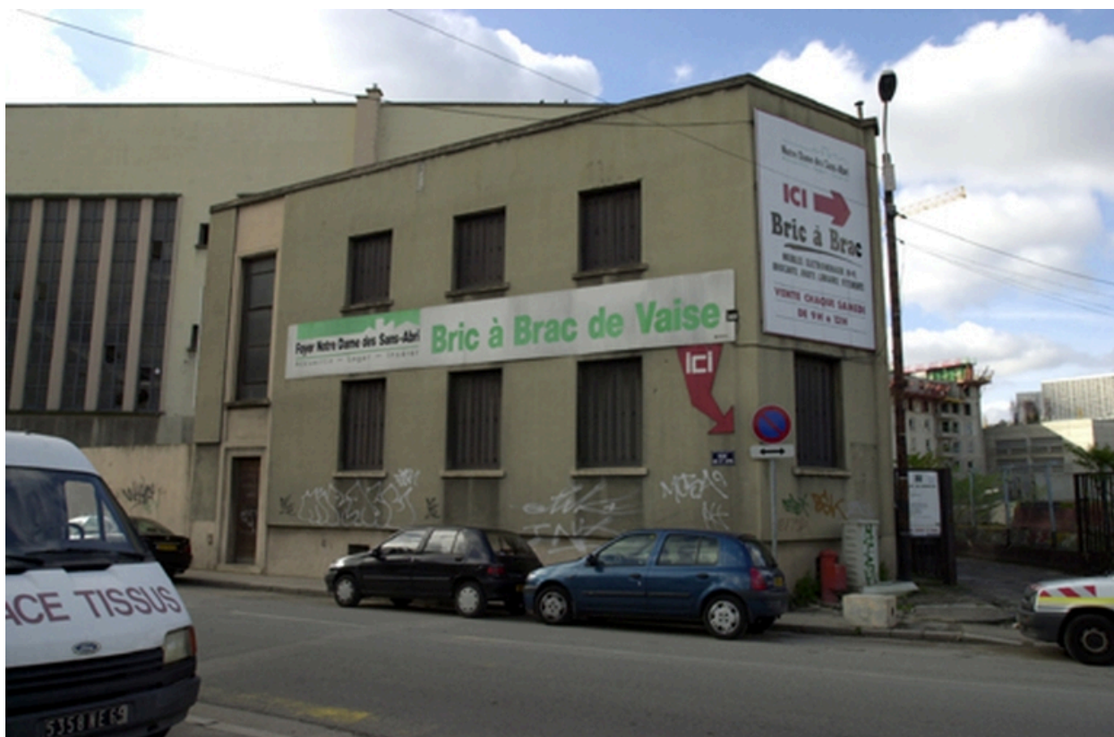
Bâtiment vue sud
