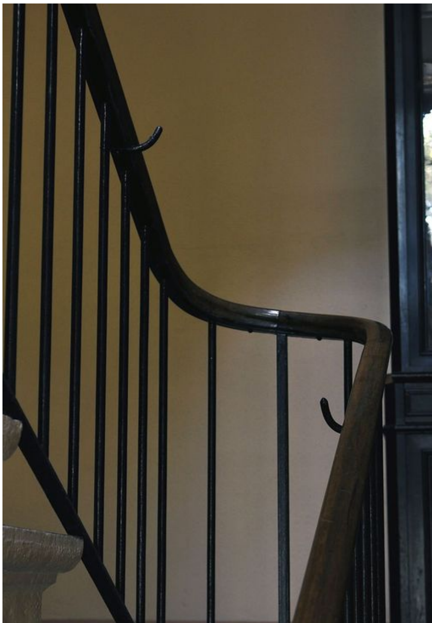
Escalier, détail : crochets pour empêcher les descentes par glissade sur la rambarde.
