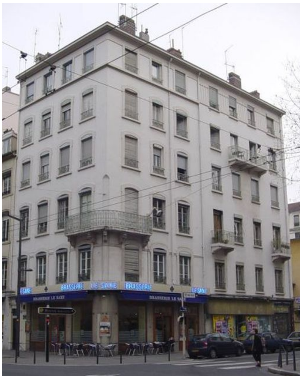
Vue générale de l'élévation
