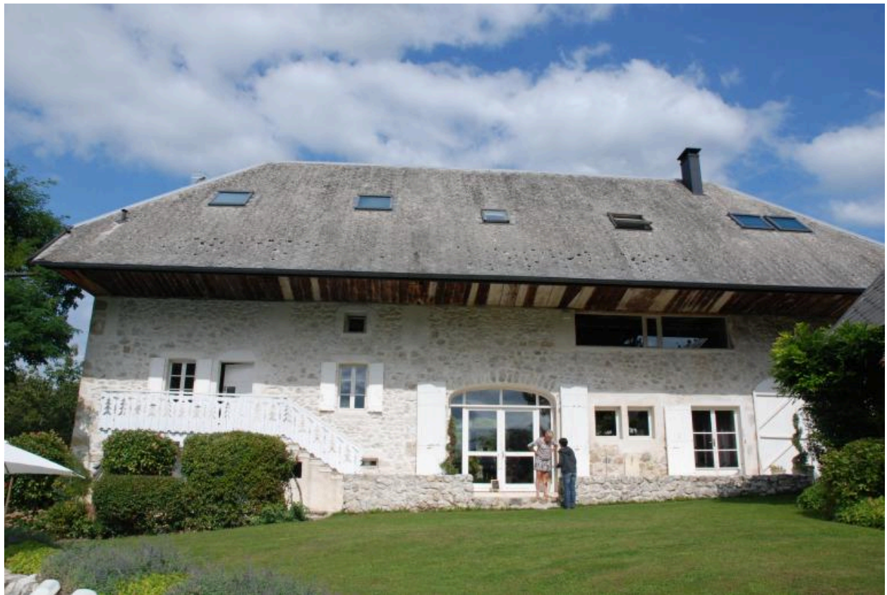
2015 A6 600, Chez Menthon, ferme. Vue d'ensemble de la façade principale de la ferme.
