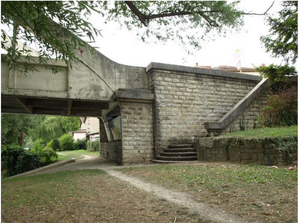
Vue partielle, culée droite, face amont (depuis la rive droite)
