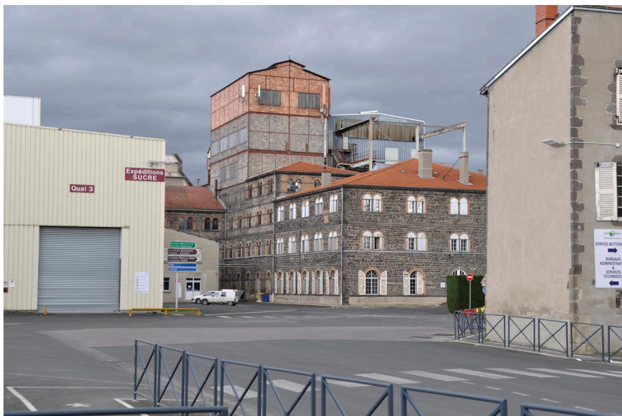
Vue de l'extérieur : grand bâtiment administratif de plan carré
